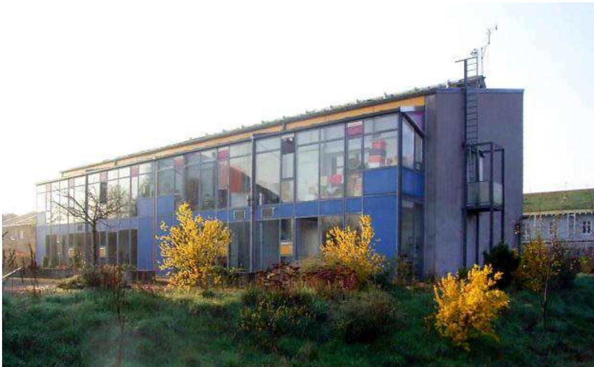
**Aufnahme** Passivhaus Darmstadt Kranichstein von **Nordosten**; der Wintergarten ist gut erkennbar, in Höhe der Decke über EG die Luftansauggitter der vier individuellen Lüftungsanlagen.
