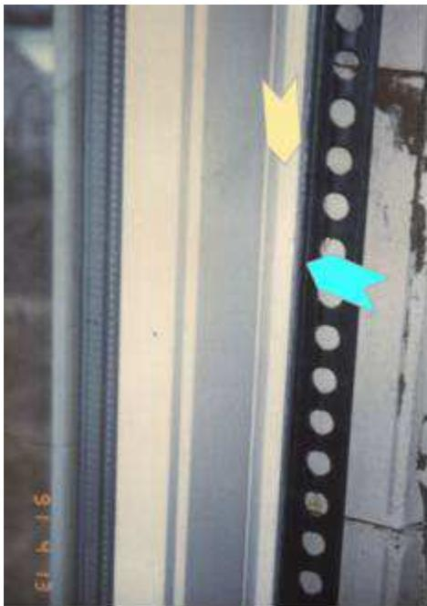
**Außenwand:** Für die Luftdichtung im Bereich der Außen- und Wohnungstrennwände wurde im Passivhaus ein vollflächig aufgebrachter Innenputz aus Gips verwendet. Es wurde speziell darauf geachtet, dass alle Mauerwerksbereiche vollständig verputzt wurden: Insbesondere auch die Bereiche, die im fertigen Innenraum gar nicht sichtbar sind. Der Putz reicht also von Oberkante Rohfußboden bis Unterkante Rohdecke.
