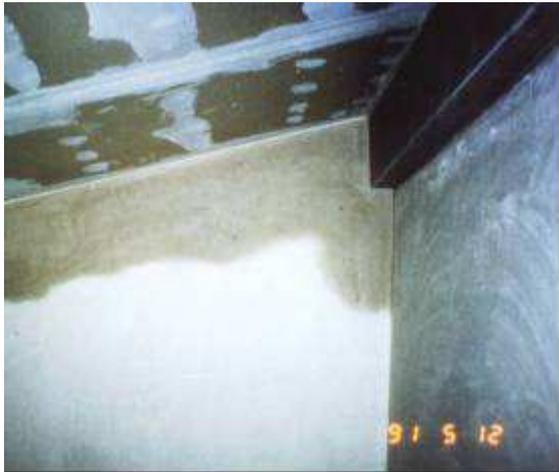
Beim Dach (Leichtbauteil) bildet die PE-Folie die luftdichte Lage, bei der Massivwand der durchgehende Gipsputz. Ein absolut dichter Anschluss dieser beiden Ebenen wurde durch Einputzen möglich: Die Folie wurde vor dem Anbringen des Innenputzes verlegt - dies hat darüber hinaus den Vorteil, dass die Feuchtigkeit während des Putzens nicht in die Leichtbaukonstruktion eindringen kann. An den Rändern zu Massivbauteilen wird die
